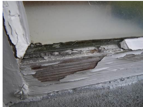
Geschädigter Kittfalz
