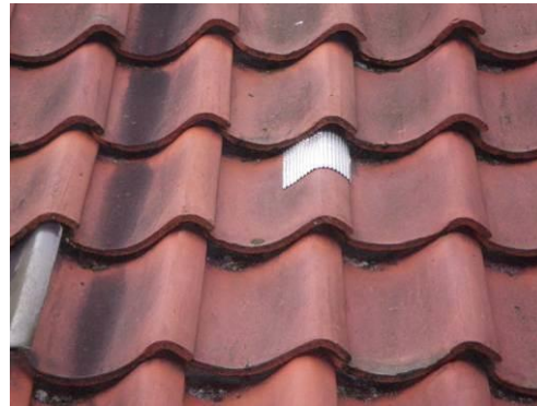
Provisorische Reparatur des Schadens
