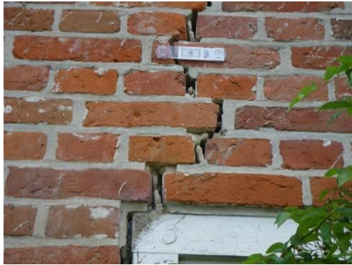
Ansicht Riss mit Rissmonitor
