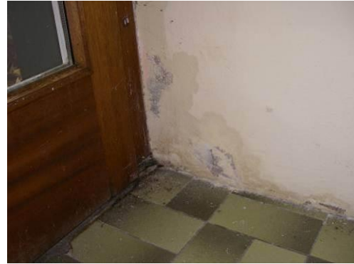
Folge: Feuchtigkeit im Inneren des Gebäudes
