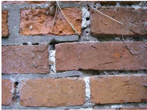
Ausbrechende Zementmörtelfugen
