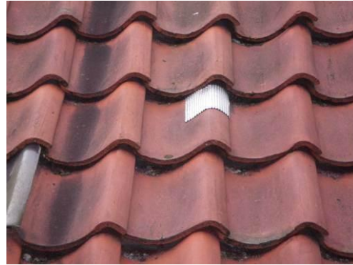
Provisorische Reparatur des Schadens
