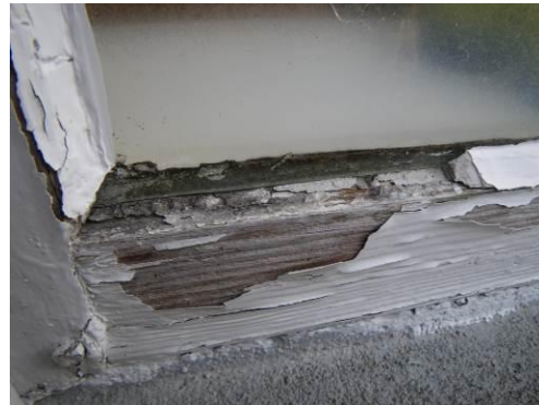
Geschädigter Kittfalz
