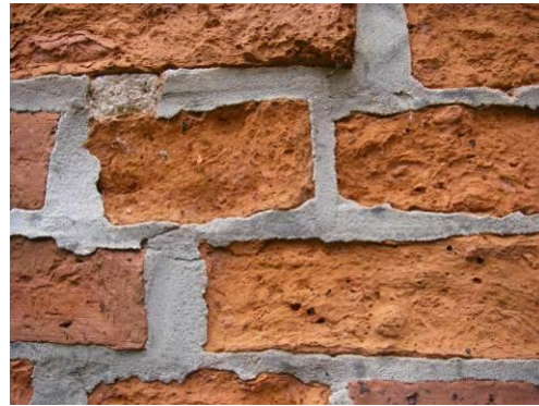
Durch den Mörtel wird die Steinoberfläche geschädigt
